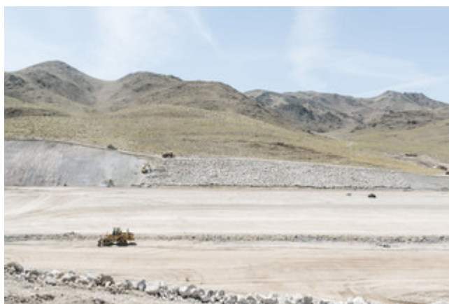
De Gigafabriek in aanbouw in September 2015. Foto: Jonathan Sprague / Redux / HH
