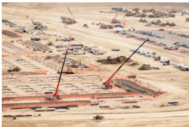
De Gigafabriek in aanbouw op 18 november 2014. Foto: James Glover/ Reuters / ANP
