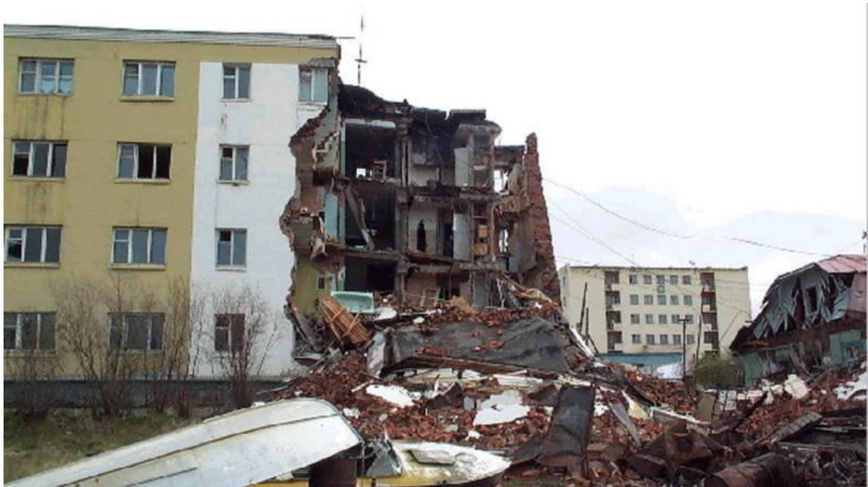
Een huis dat is verzakt door het ontdooien van de permafrost NOS
